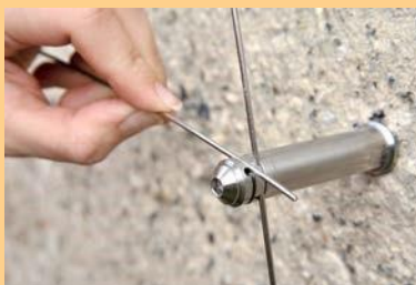
Napněte nerezový drát
