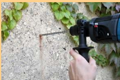
Vyvrtejte otvor a připravte kotvení
