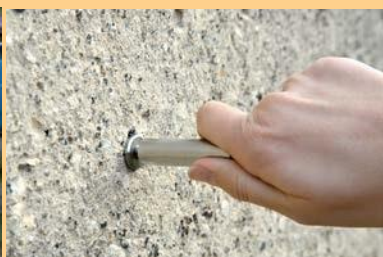
Vyvrtejte otvor a připravte kotvení
